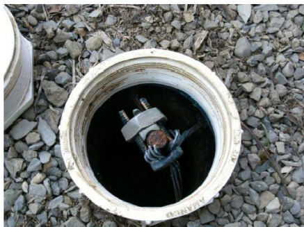
Figura. Instalación de electrodos de puesta a tierra.
